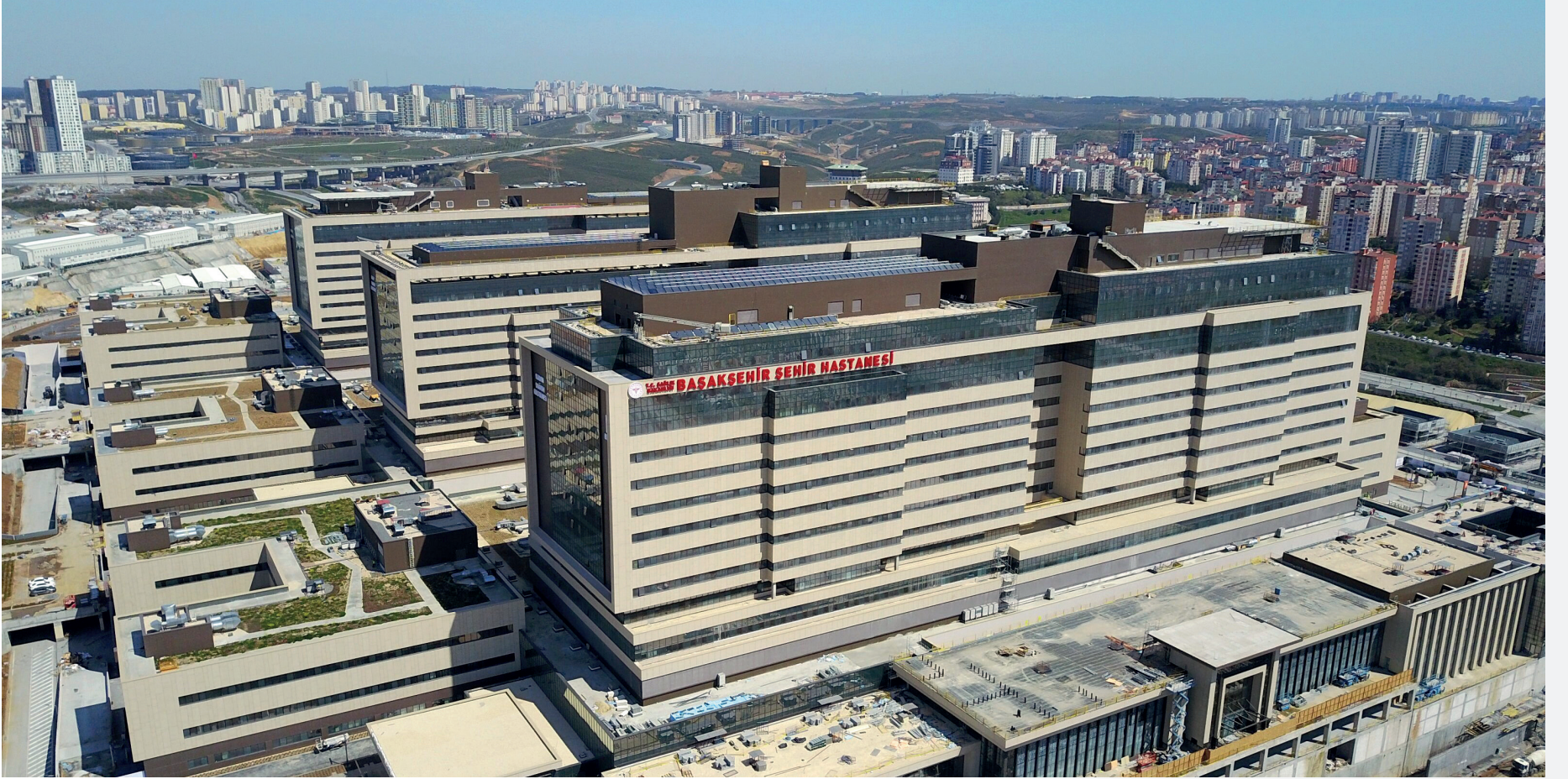
Başakşehir Çam ve Sakura Şehir Hastanesi
